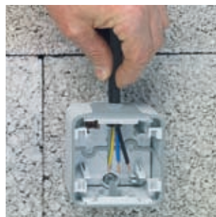
3/ Cofnij przewód lekko do góry w celu odpowiedniego ułożenia uszczelki
