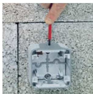
1/ Przebij membranę śrubokrętem
