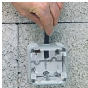
2/ Wprowadź przewód do przygotowanego otworu
